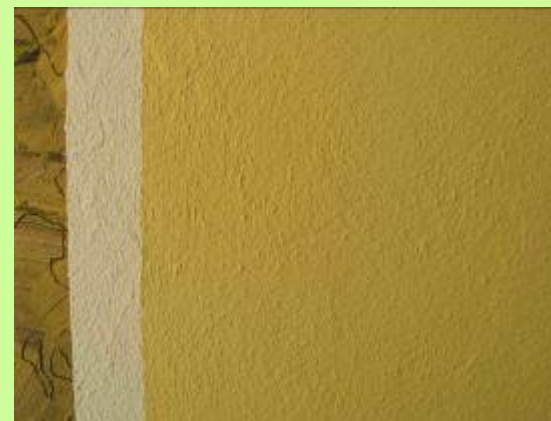
Слева-направо: дисперсионная органическая краска/силикатная краска Кайм Зольдалит® белая/силикатная краска Кайм Зольдалит® тон 9033
