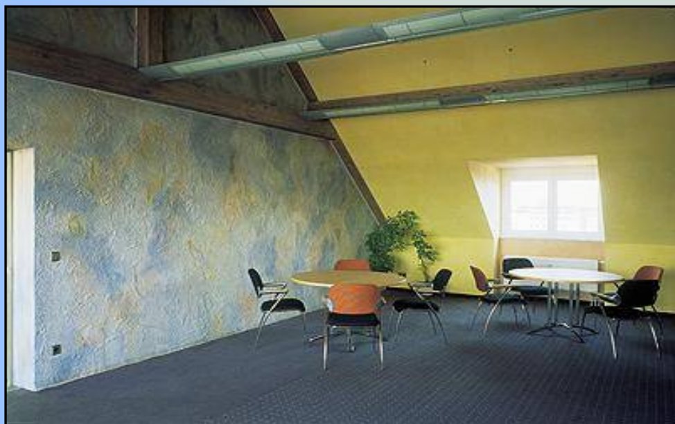
Офис г. Унтершляйсхайм (Германия). Примененные материалы: силикатная краска Keim Biosil, Keim Lasur
