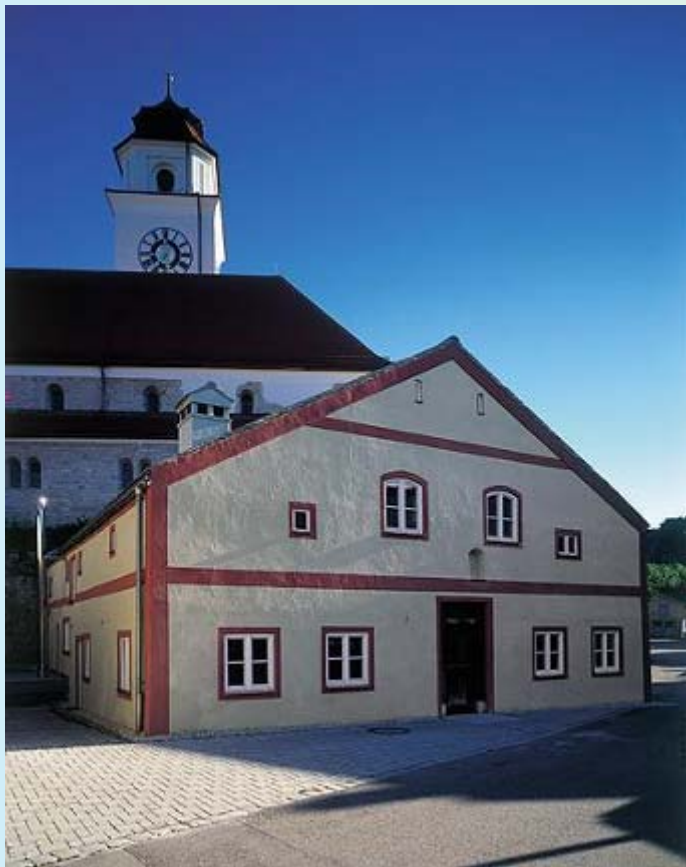
Церковный дом кирхи "Свв. Петра и Павла" г. Доллнштайн Система: фасад - Keim Purkristalat®, интерьер - Keim Biosil®
