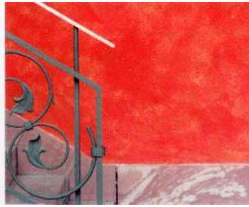
Илл. 3. Лестничный вход, окрашенный предварительно силикатной краской желтого цвета и затем - кирпично-красной силикатной лазурью.
