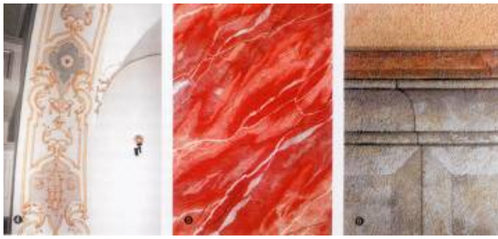
4 - реконструкция силикатной живописи в церкви "Св. Петр" в Обхаузене; 5 - живопись под мрамор, Альтен Музеум, Берлин; 6 - рабочая проба силикатными лазурями
