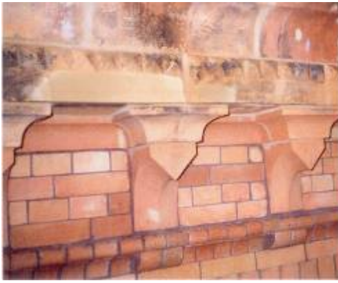
Илл. 2. Старая стена из обожженного клинкерного кирпича, после очистки выровнена по цвету силикатными лазурями и закреплена (пробный участок)
