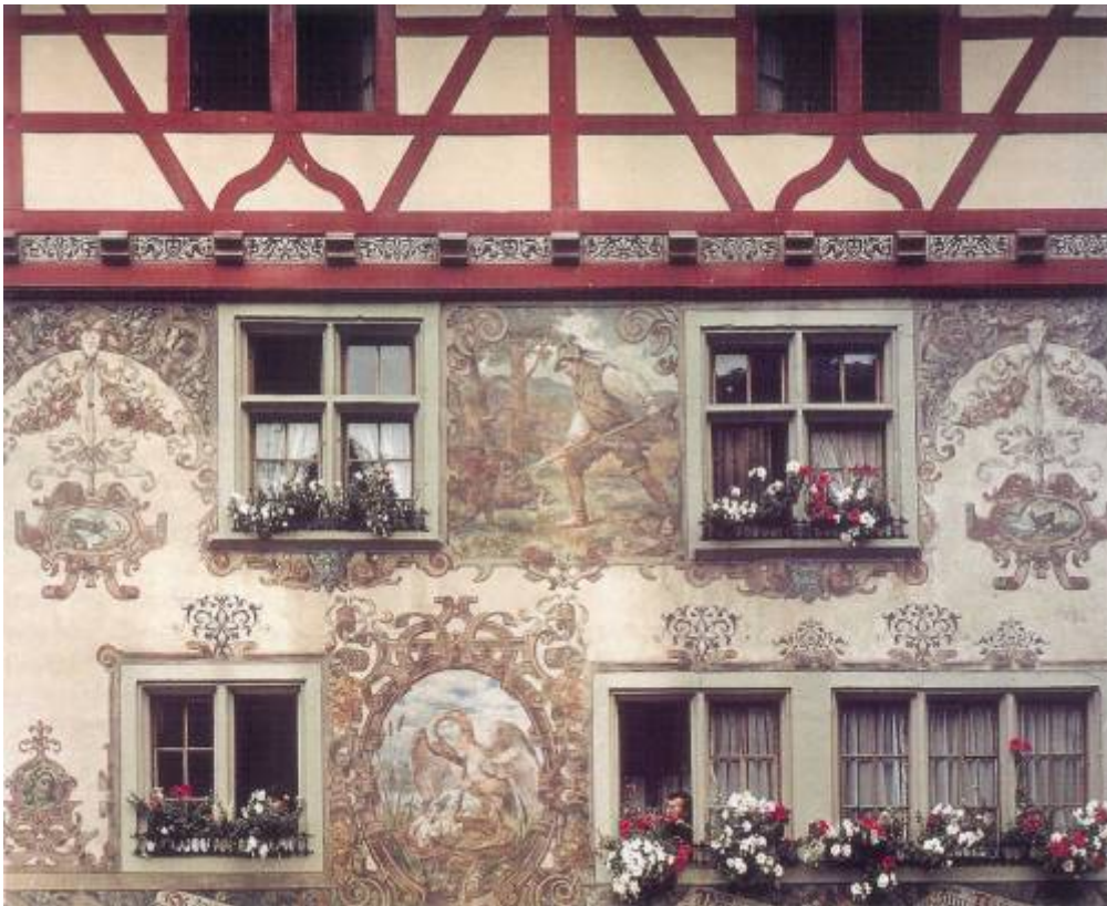
Илл. 7. Настенная живопись в стереохромии (“А-техника”) выполнена в 1900 г. с промежуточной реставрацией. Ратуша в г. Stein/Штайн, Швейцария. Минеральные силикатные краски немецкой фирмы Keimfarben
